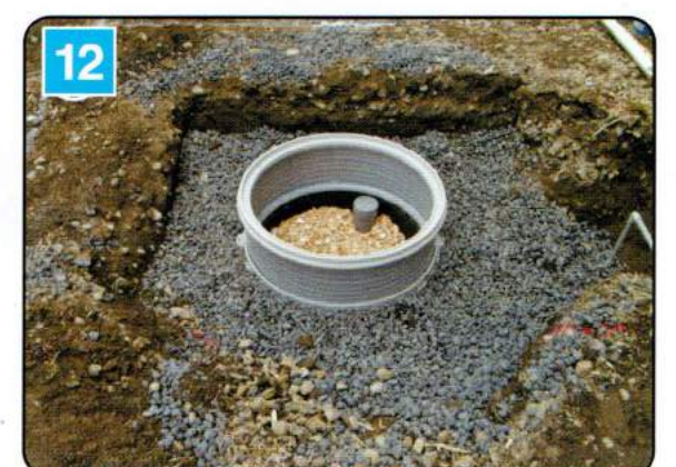
嵩上げ材設置
