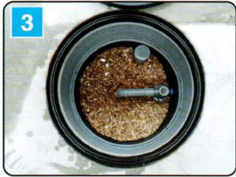
③ バイオクリーン内部の状況確認 マンホールを開けて内部の状況確認をし配管の異常やエアリフトポンプの稼動状況を確認します。
