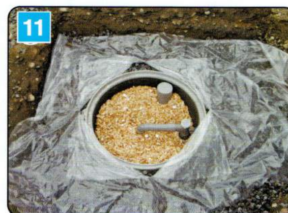
止水シート設置（雨水流入防止）
