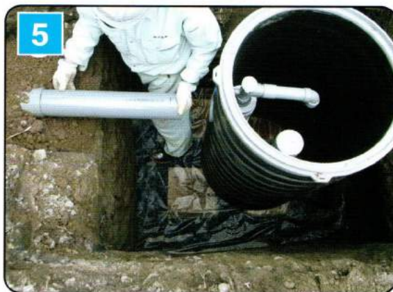
本体設置・流入配管接続
