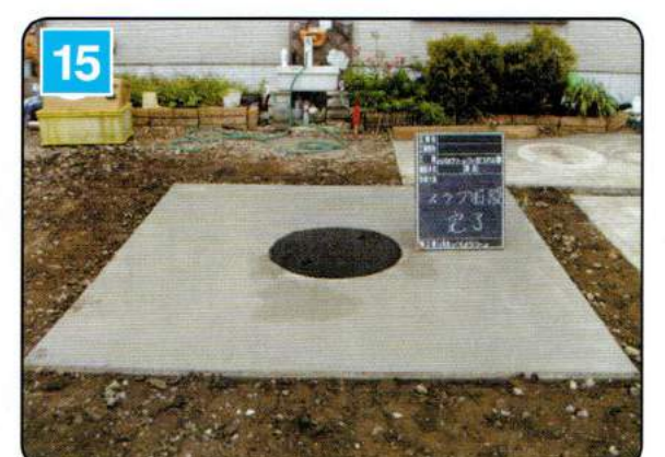
スラブコンクリート打設完了
