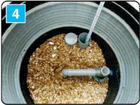
④ 槽内水位の確認 検水管のフタを外し、検水管内部の水位の確認をします。
