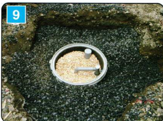
砂利埋め戻し（完了）
