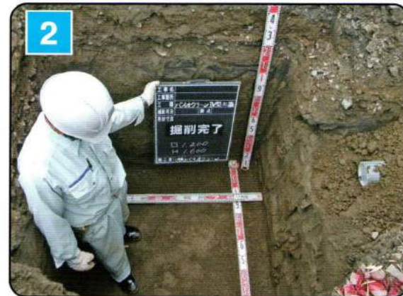
掘削：指定の寸法通り掘削します。
