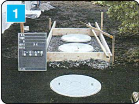
① バイオクリーン周辺の状況確認 バイオクリーン槽の傾きや槽周辺の陥没など、不具合が無いか確認します。
