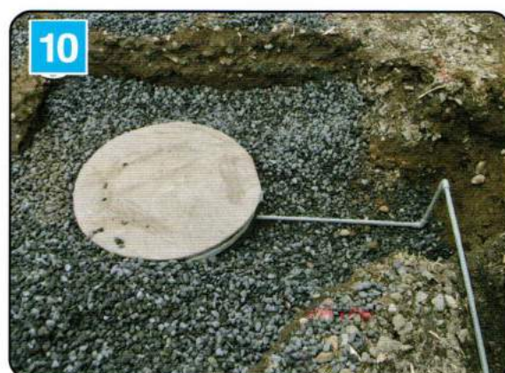
ブロワ配管（VP13φ）接続
