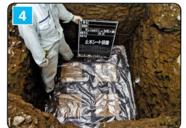
止水シート設置（重力浸透防止）
