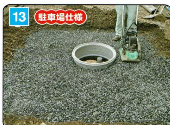
スラブコンクリート砕石転圧
